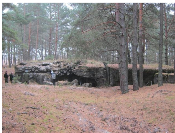
Рис. 3. Напівзруйнований ДОТ поблизу с. Тинне
